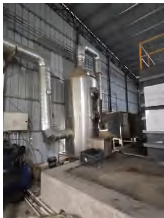
废气排放口、废气处理设施及收集管道
