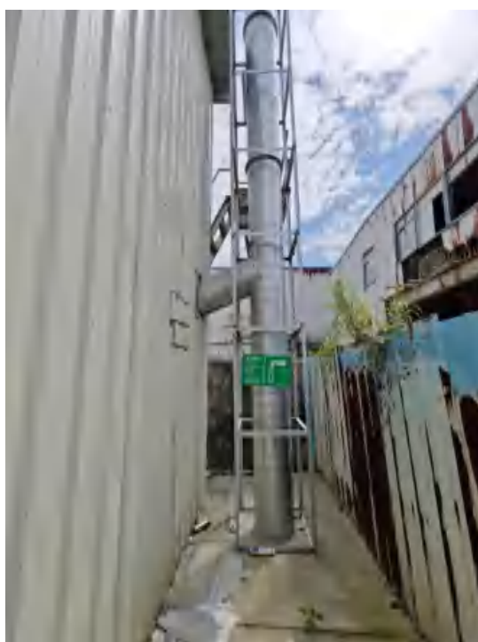
废气排放口、废气处理设施及收集管道
