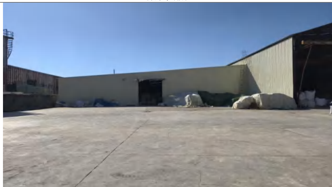
原料堆场遮盖
